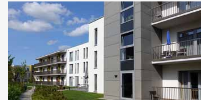
Quelle: fmr Architekten Greifswald
